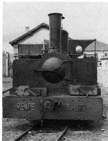
Vista frontal de la locomotora Nº2 "Berrocal" (Renfe 030-0299). La desproporción entre el gálbo de la máquina respecto al ancho de la vía es evidente. (Colección Javier Aranguren.)
