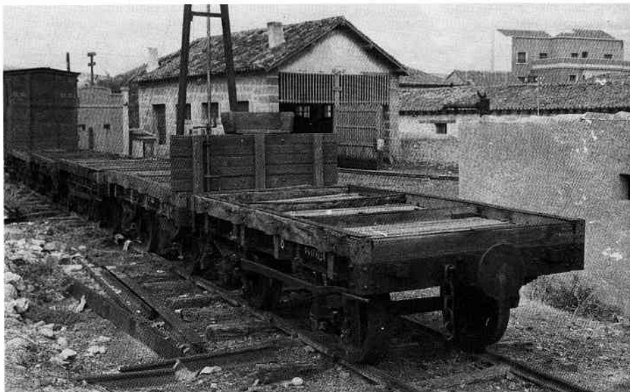
Algunos de los numerosos vagones-plataforma que poseía el ferrocarril, estacionados en Villalba. Obsérvese el asiento para el guardafrenos. (Colección Javier Aranguren.)
