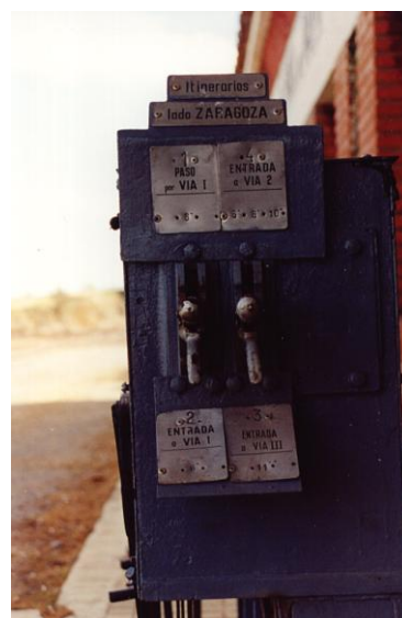
Perspectiva de la mesa de enclavamiento eléctrica de la estación de Cariñena y lateral de la mesa de enclavamiento mecánica de la estación de Villarreal de Huerva.
