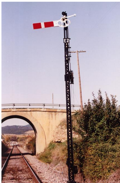
A la izquierda semáforo de entrada con accionamiento mecánico de la estación de Villarreal de Huerva lado Caminreal, obsérvese el brazo que no responde al modelo original. A la derecha semáforos de entrada con accionamiento eléctrico de la estación de Caminreal lados Zaragoza y Calatayud, cuando ya se encontraba cerrada al servicio esta estación, por lo que el semáforo lado Zaragoza que rebasa el automotor MAN s/592.0 fue desconectado del enclavamiento y colocado en la posición de vía libre, el semáforo lado Calatayud permanece en parada desde el 1-Enero-1985.
