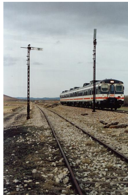
A la izquierda semáforo de entrada con accionamiento mecánico de la estación de Villarreal de Huerva lado Caminreal, obsérvese el brazo que no responde al modelo original. A la derecha semáforos de entrada con accionamiento eléctrico de la estación de Caminreal lados Zaragoza y Calatayud, cuando ya se encontraba cerrada al servicio esta estación, por lo que el semáforo lado Zaragoza que rebasa el automotor MAN s/592.0 fue desconectado del enclavamiento y colocado en la posición de vía libre, el semáforo lado Calatayud permanece en parada desde el 1-Enero-1985.
