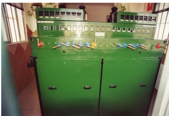
Mesa de enclavamiento mecánica y de la estación de Cadrete y mesa de enclavamiento eléctrica de la estación de Cariñena
