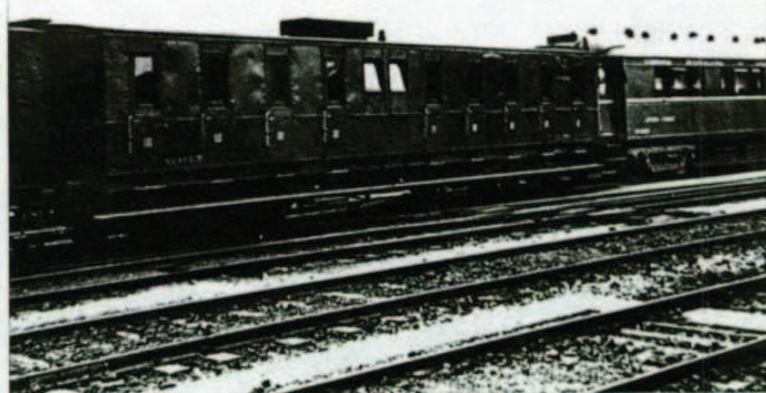
Coche de pasillo parcial, de bogies, de Andaluces. Una rareza en el parque de coches, en vía ancha.
