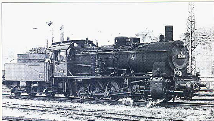
Bild 126: Nur über einen Sand- und einen Dampfdom verfügt diese G 10, die als 57 3485 noch bei der DB lief.
