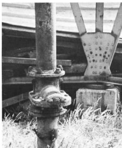
Válvula y placa de unión inferior (Pieza G)
