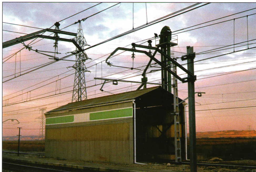
Cargadero cubierto en Seseña. Se observa en la parte posterior el elevador de cangilones. 15/1/00.
