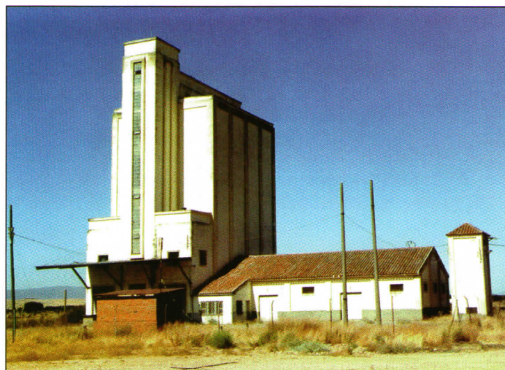
◀ Silo multicelular cuadrado de hormigón. Pueden verse también la báscula, el transformador, el almacén y las oficinas. Madrigalejo. 12/9/02
