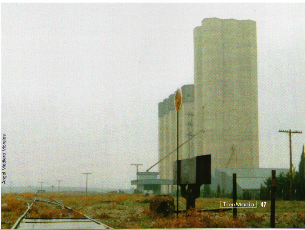
▼ Moderno silo multicelular poligonal de hormigón en Cariñena. Se observa el cargadero cubierto separado de éste. 13/10/99.
