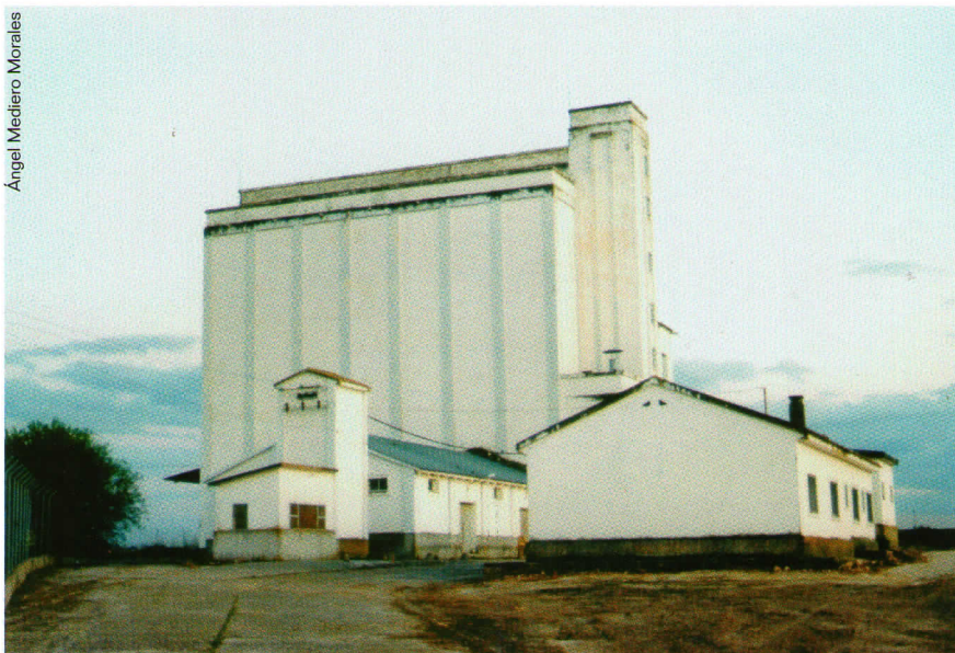
▲ Silo multicelular cuadrado de hormigón en Erustes en el que se observan todos los edificios auxiliares. Los vagones son cargados por el lateral no visible del silo. 31/03/02.
