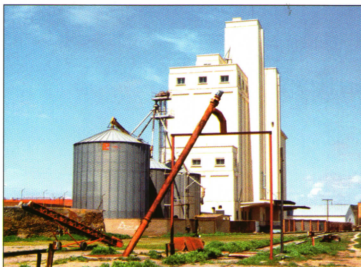
◀ Instalaciones para cereales en Almazán-Villa que muestran diversos tipos de silos. En primer plano tornillo sinfín y cinta transportadora. 2/5/00.
