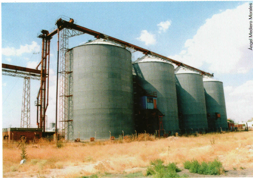
▲ Silos circulares metálicos de chapa plegada en Quintanar de la Orden, cuya estación y vías se encontraban en la explanada que hay delante de ellos. 12/07/03.
