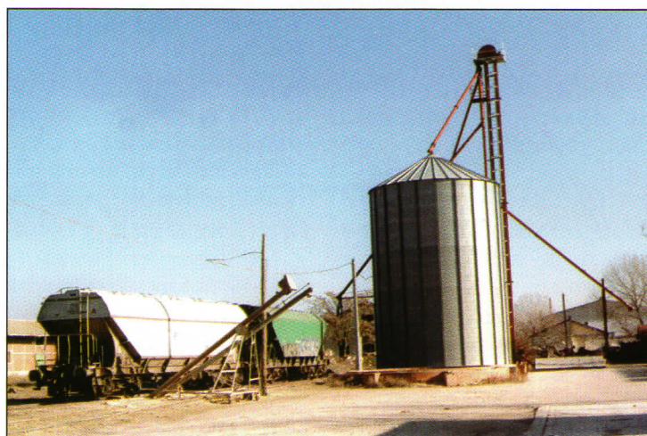
◀ Silos circulares metálicos de base plana. A destacar el elevador de cangilones y las tuberías de distribución. Aranda-Chelva. 6/12/02.
