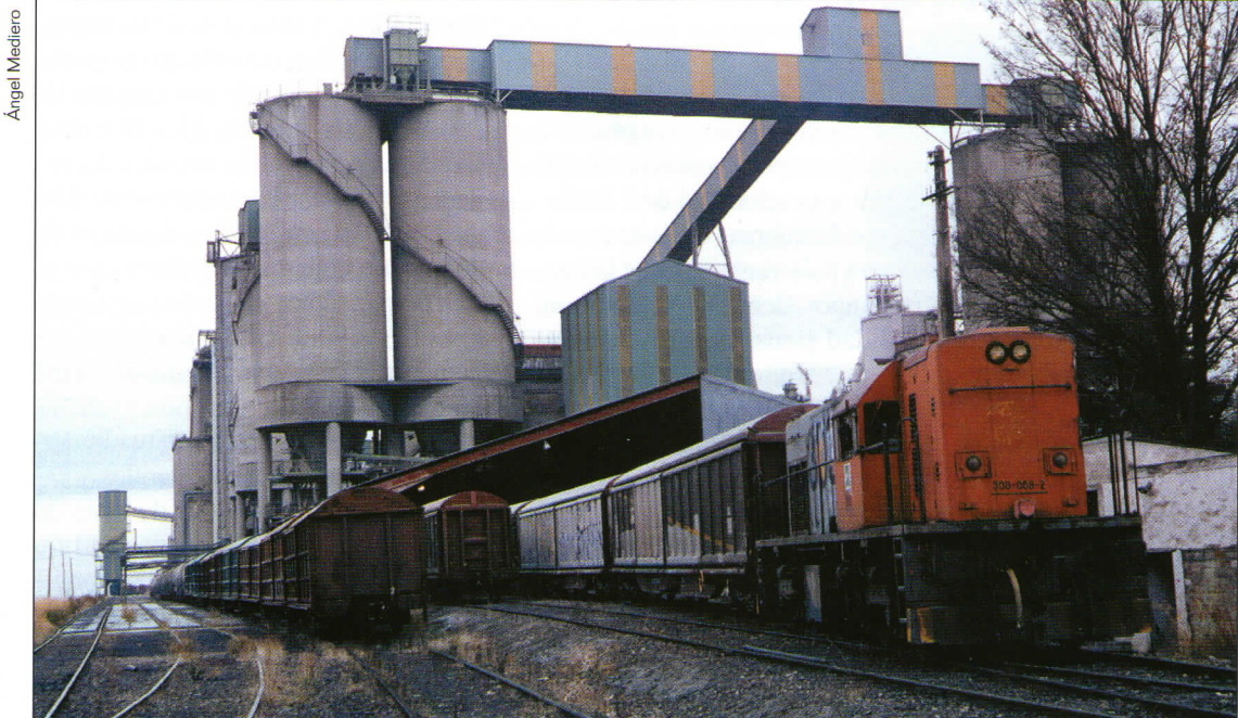
◀ Muelle cubierto para la carga de sacos de cemento a vagones de paredes deslizantes en Villaluenga-Asland. 5/12/00
