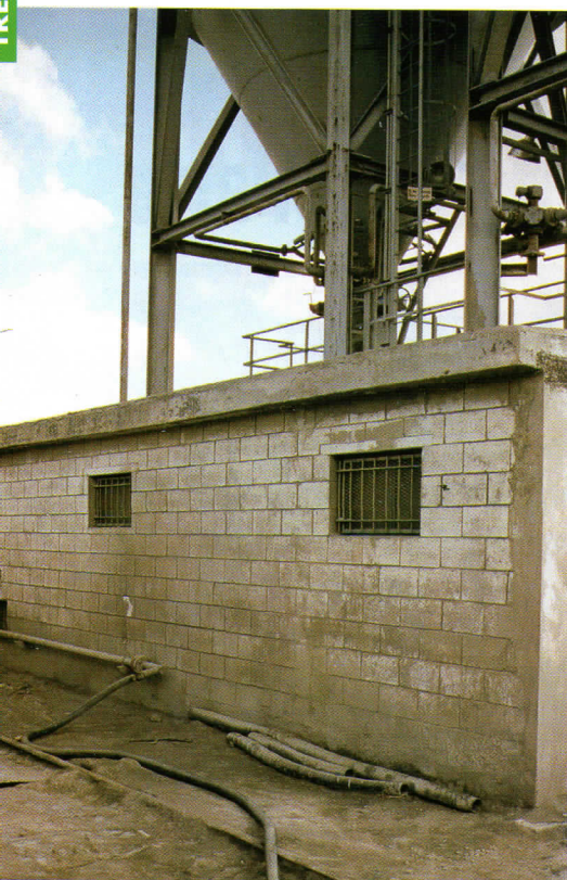
▲ Caseta que alberga el equipo neumático para el trasvase del cemento de las tolvas al silo posterior. Observad el cemento fraguado sobre la vía. Soria. 19/10/96.
