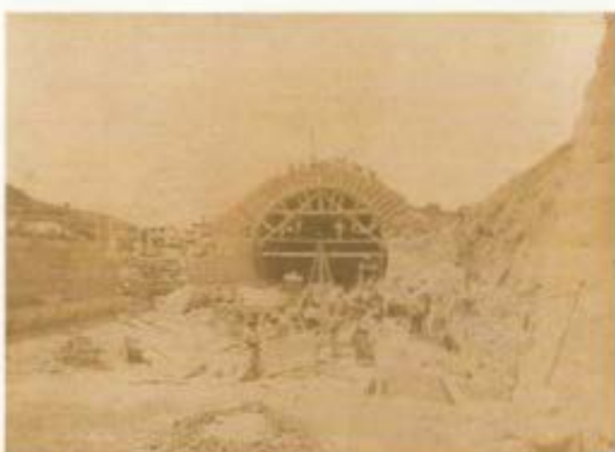
Construcción de un túnel a cielo abierto hacia 1900
