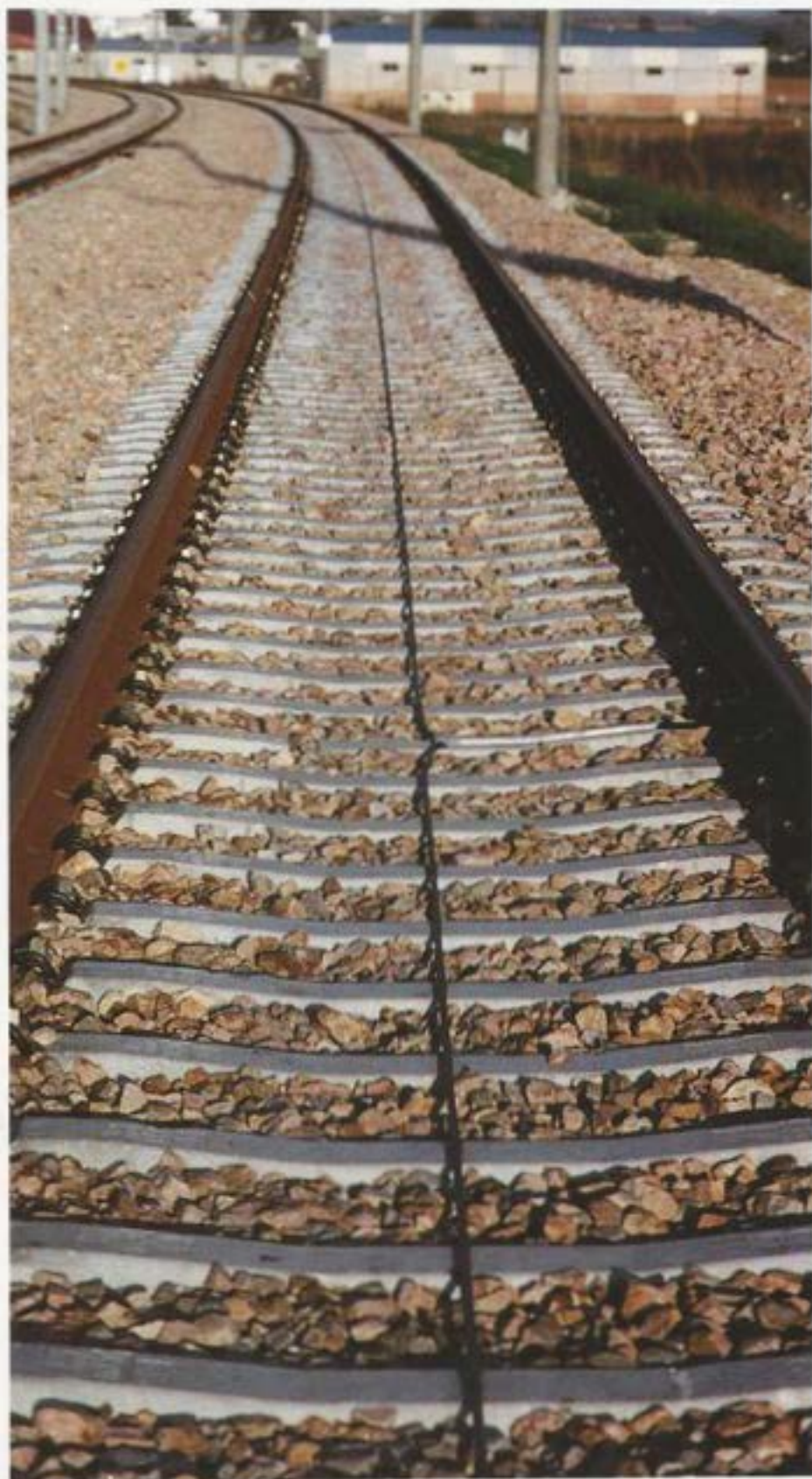
El empleo de las traviesas de hormigón se empezó a generalizar en España en la década de los cuarenta
