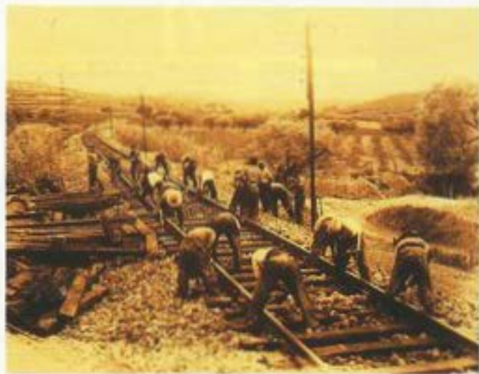
Montaje de traviesas y raíles hacia primeros de siglo. (Foto G.I.R.E. de Renfe.)
