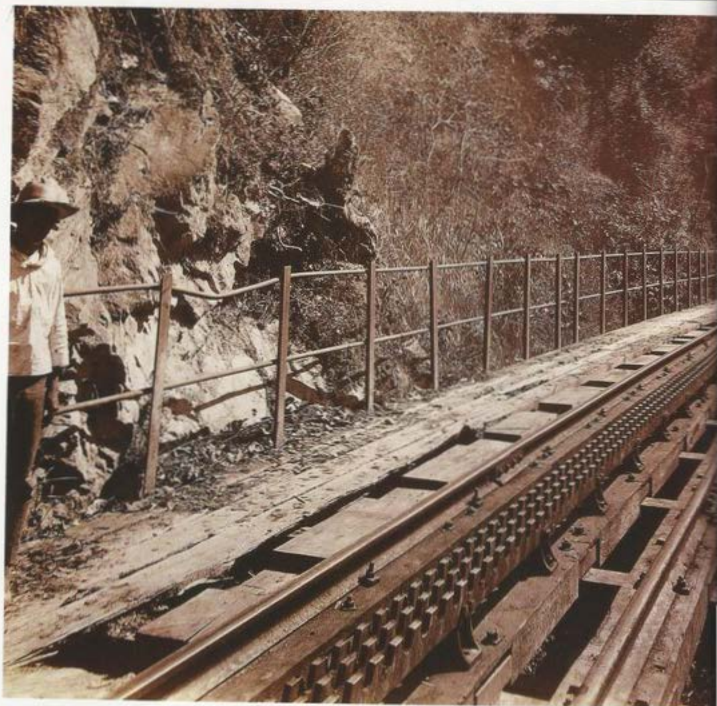
Dispositivo de cremallera en el ferrocarril de Puerto Cabello a Valencia. (Archivo Palacio Real.)
