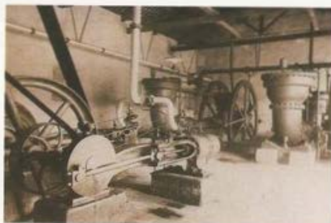
Cuarto de compresores para la perforación de un túnel hacia 1900
