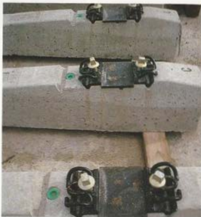
Las traviesas actuales son de hormigón postensado monobloque. (Foto G.I.R.E. de Renfe.)
