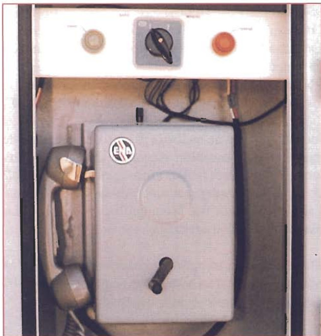
Armario de Mando Local y Teléfono.
