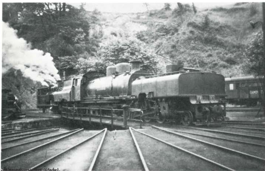
La «Garratt» 83 de La Robla, fotografiada en el depósito de Valmaseda en junio de 1955. Obsérvese que su longitud es mayor que la de la placa giratoria en que se encuentra. Esto era normal en las «Garratt» (incluso en RENFE) y normalmente se las daba la vuelta en triángulo.
