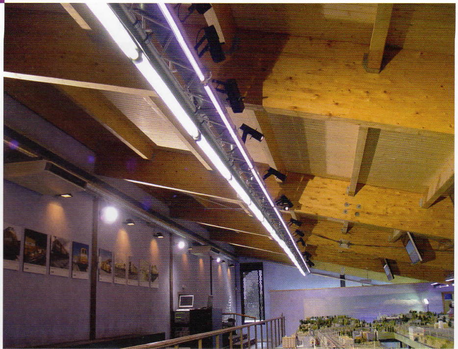
Ejemplo de utilización de de fluorescentes con apoyo de cañones de luz. Este montaje es profesional pero puede servir de ejemplo, como idea básica y salvando las distancias, para un aficionado.
