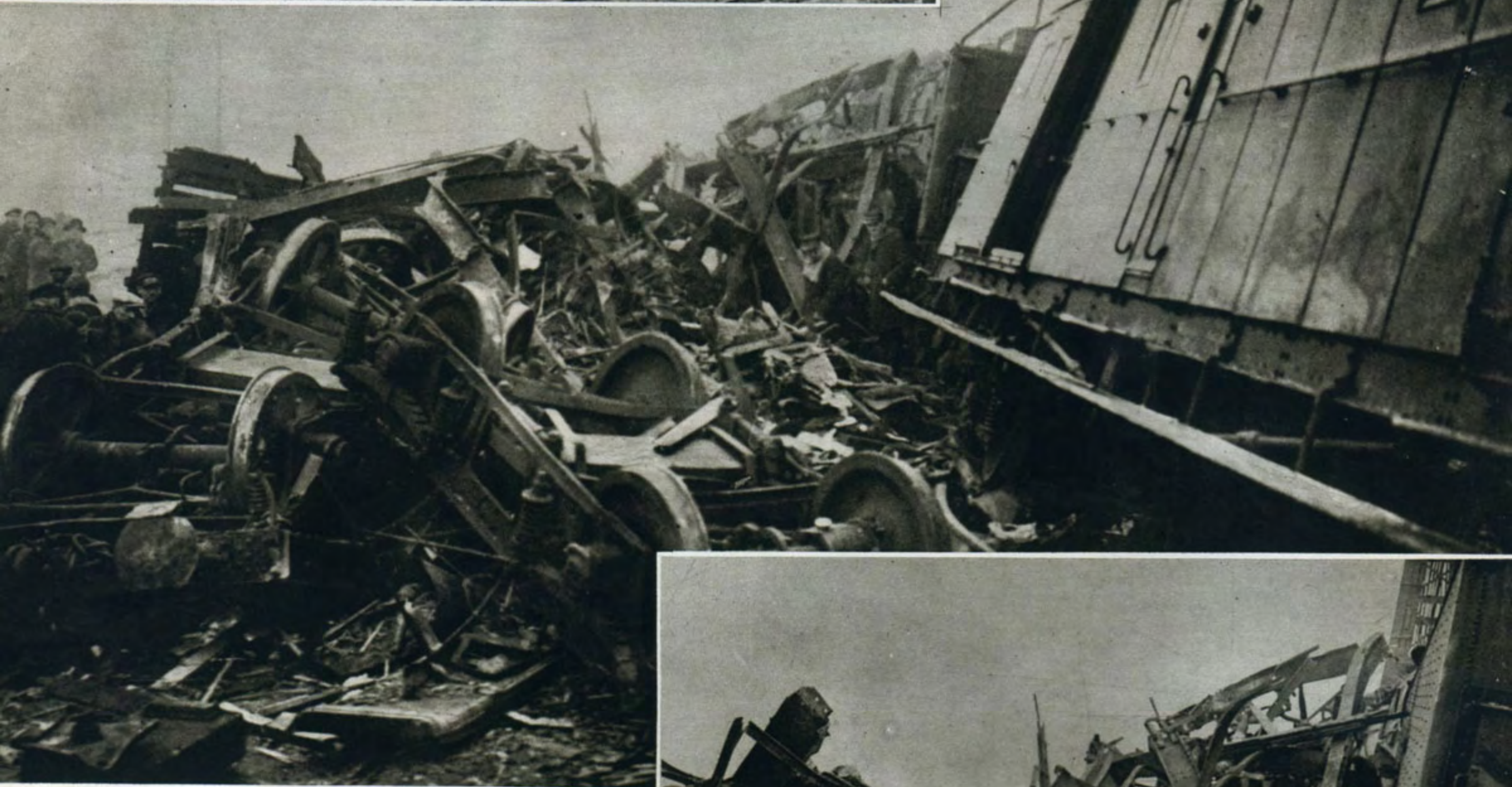
FIG. 11. ASPECT DE LA LOCOMOTIVE DU TRAIN TAMPONNEUR DANS L'ACCIDENT DE LAGNY. — LES VOITURES EN BOIS SONT ENTIEREMENT DETRUITES. LES VOITURES METALLIQUES ONT RESISTE. (PHOTO « ACTUALIT ».)
