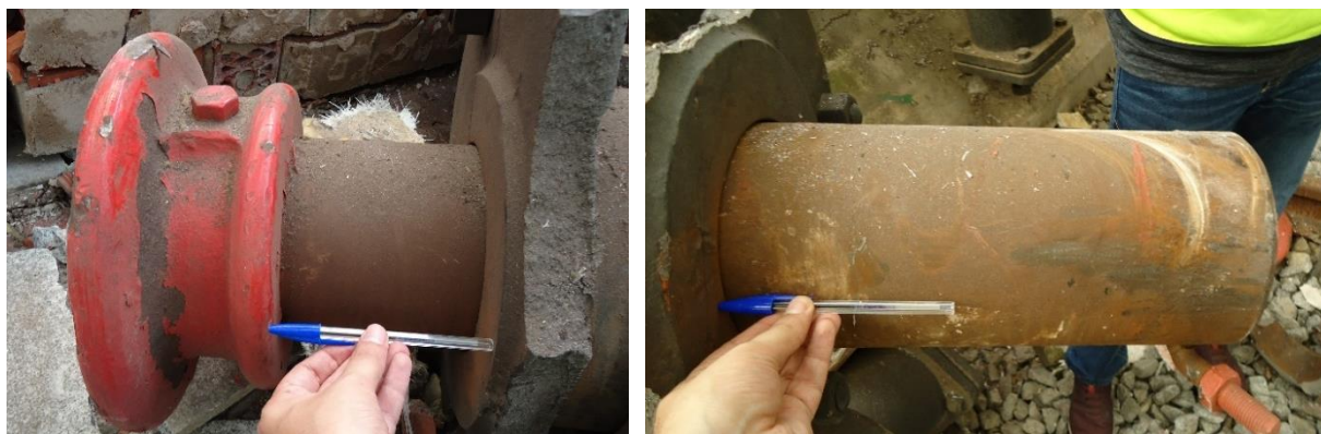
Figura 14: desplazamiento de los émbolos de la topera de la vía 11 (compárese con la posición original que se aprecia en la topera de vía 12, en la imagen de la figura 12)
