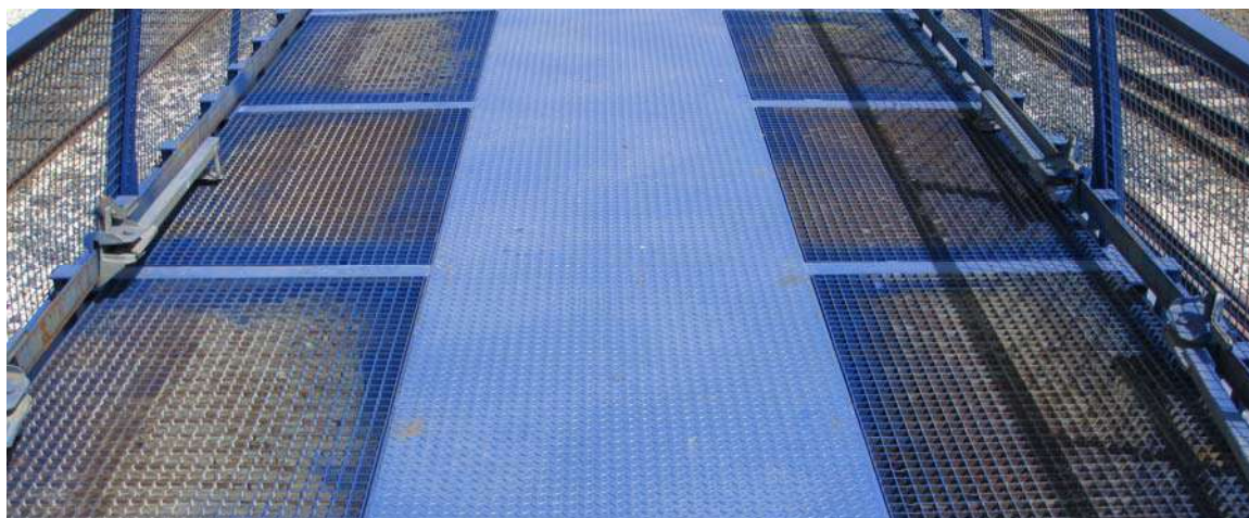
Figura 36 - Diferentes soluciones para el suelo del piso
