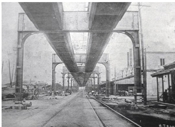
Figura 8. Construcción de los pasos elevados de la estación Central de Ferrocarril de La Habana, 1911
