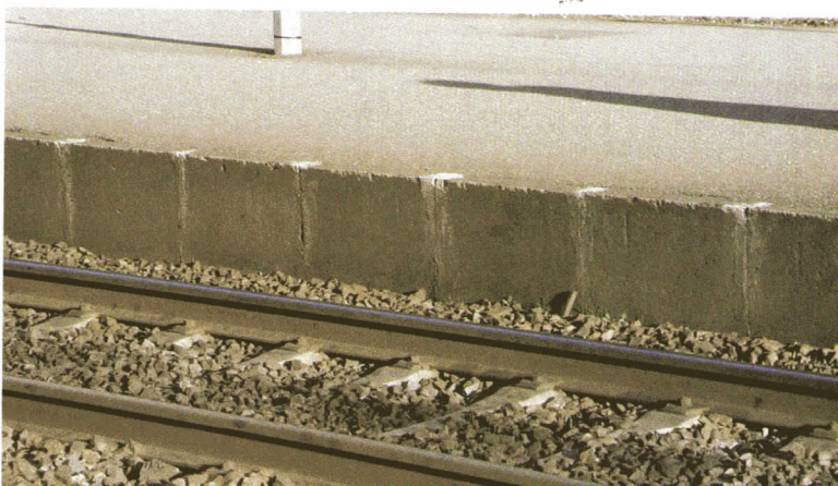
5. Andén de perfil bajo, de 385 mm, construido con bordillos de hormigón.
