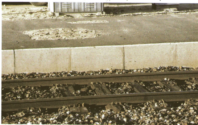
3. Andén de perfil bajo, de 300 mm, realizado recientemente con bordillos de hormigón.
