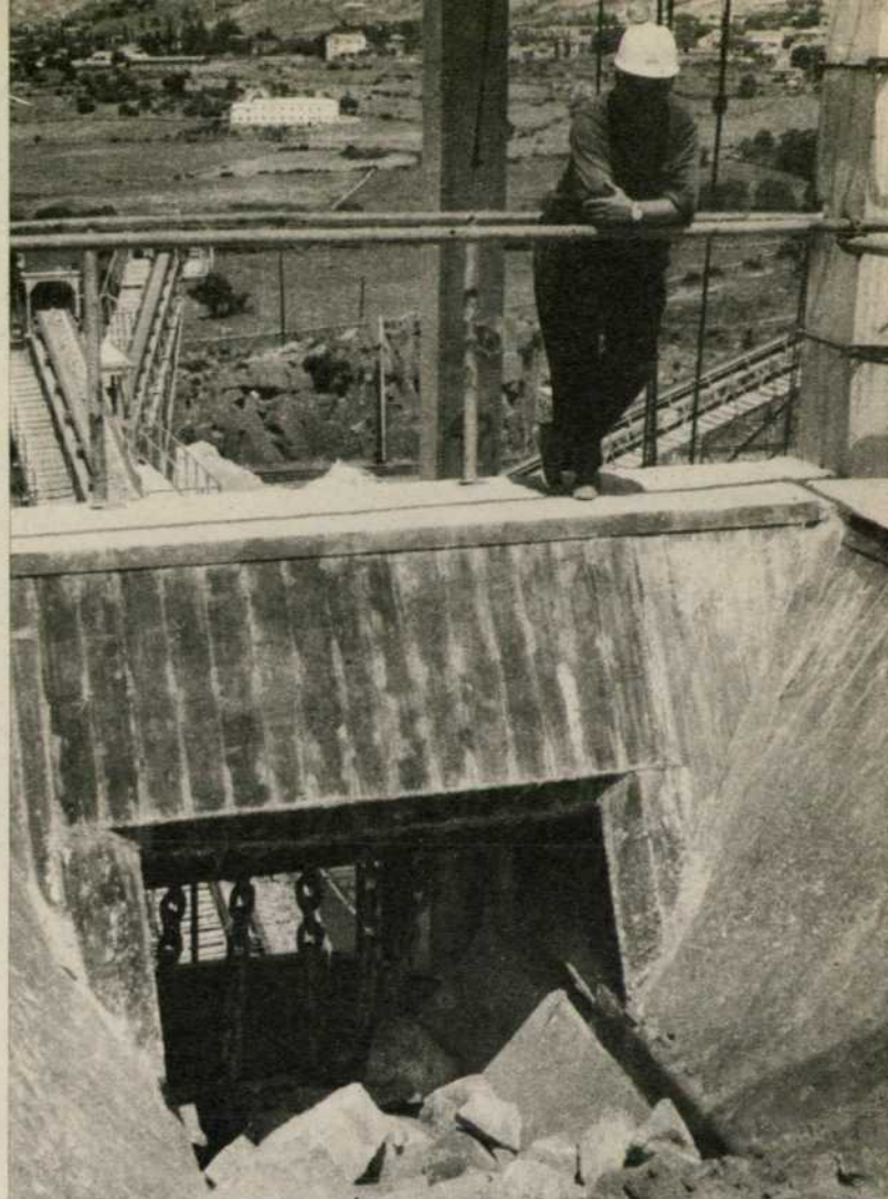
Boca del sistema de criba.
