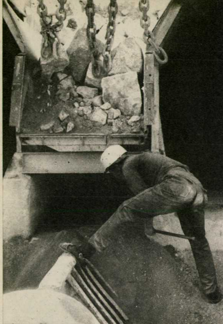
Por el orificio, que en este momento limpia un obrero, sale el balasto, la arena y la gravilla.
