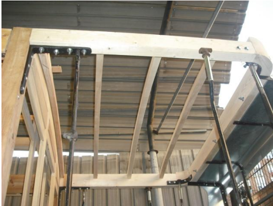
8º-5 UNION DE LAS CABINAS AL RETO DE LA ESTRUCTURA POR EL TECHO
